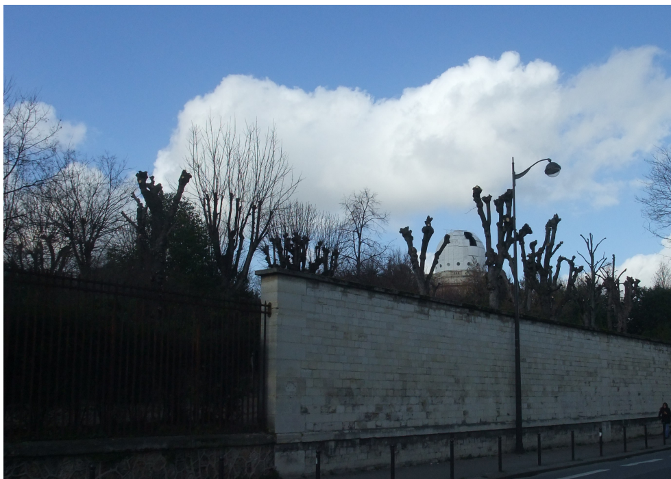
Fig. 7.7. La limite sud de l'Observatoire, le long du boulevard Arago. Photo © Danielle Fauque
